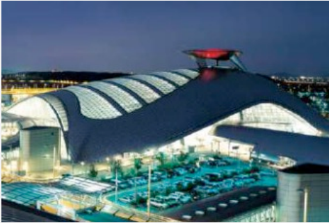
Incheon Uluslararası Havaalanı Terminal 2 Güç Kontrol Sistemi ('13 ~ '17)
